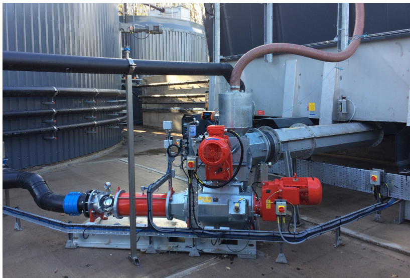
Obrázek 7: Zařízení premix od firmy Vogelsang umožňující řezání stébelnatých materiálů před vstupem do BPS.
